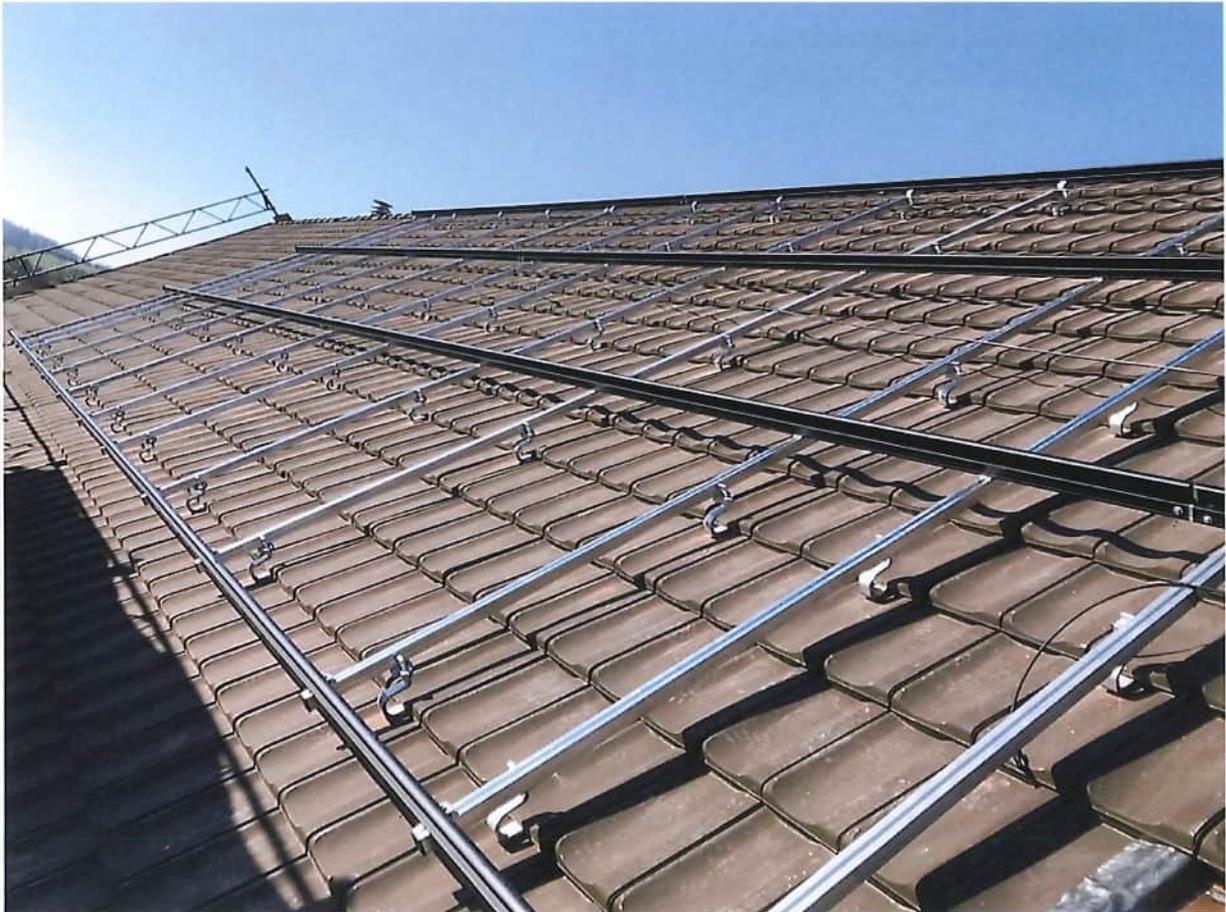
Im Kreuzverbund montiert gehört das Einlegesystem zu den stabilsten Bauformen auf dem Markt. Die Module werden im Vergleich zum Klemmsystem weniger belastet und man erreicht eine höhere Stabilität. Die horizontalen Einlegeschielen - und bei Bedarf auch die vertikalen Trägerschienen – sind schwarz eloxiert und versprechen eine ansprechende Optik und ein harmonisches Gesamtbild auf dem Dach.
